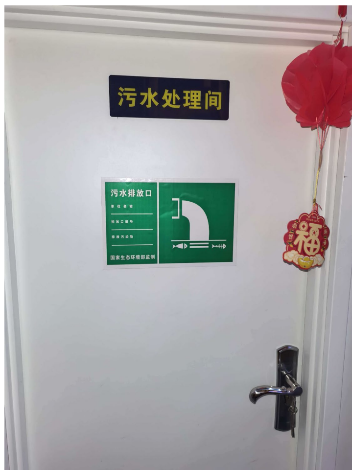
图4-2 本项目医疗废水处理设施情况
