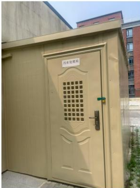
图 2-6 污水设备操作间照片
