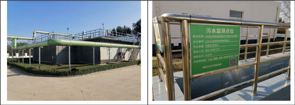
图 4-2 琉璃河污水处理厂现状照片
