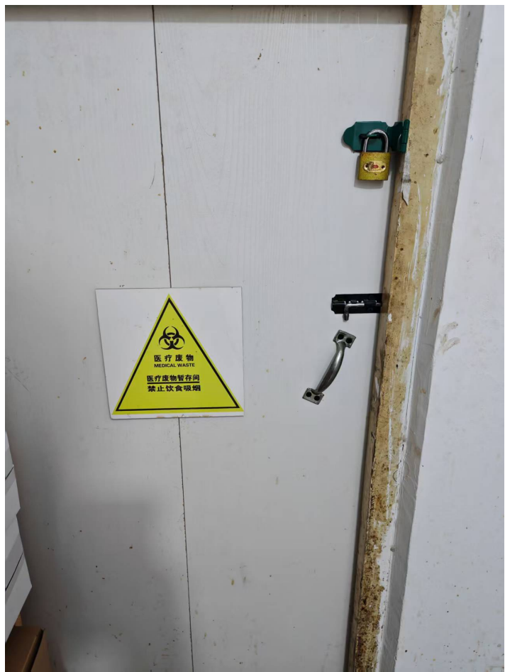
图4-3 本项目医废间暂存间情况
