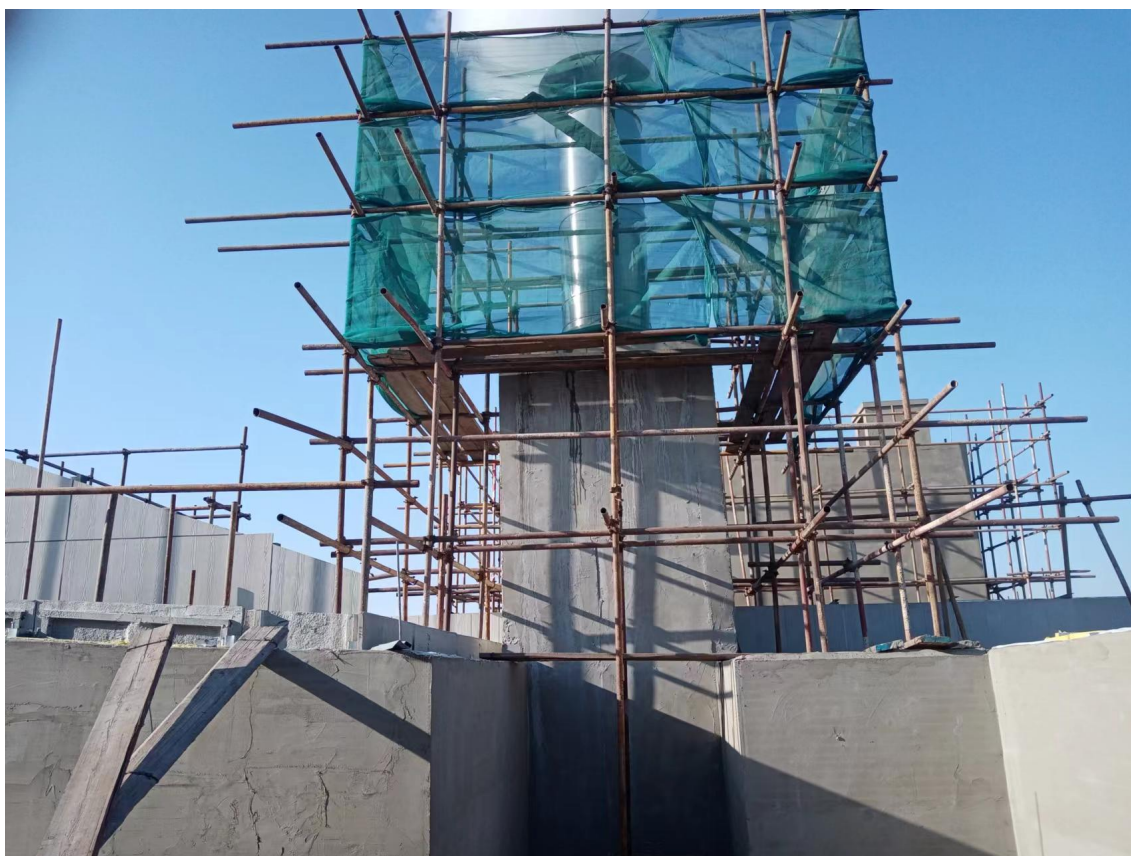
图4-3 本项目锅炉房烟囱现状
