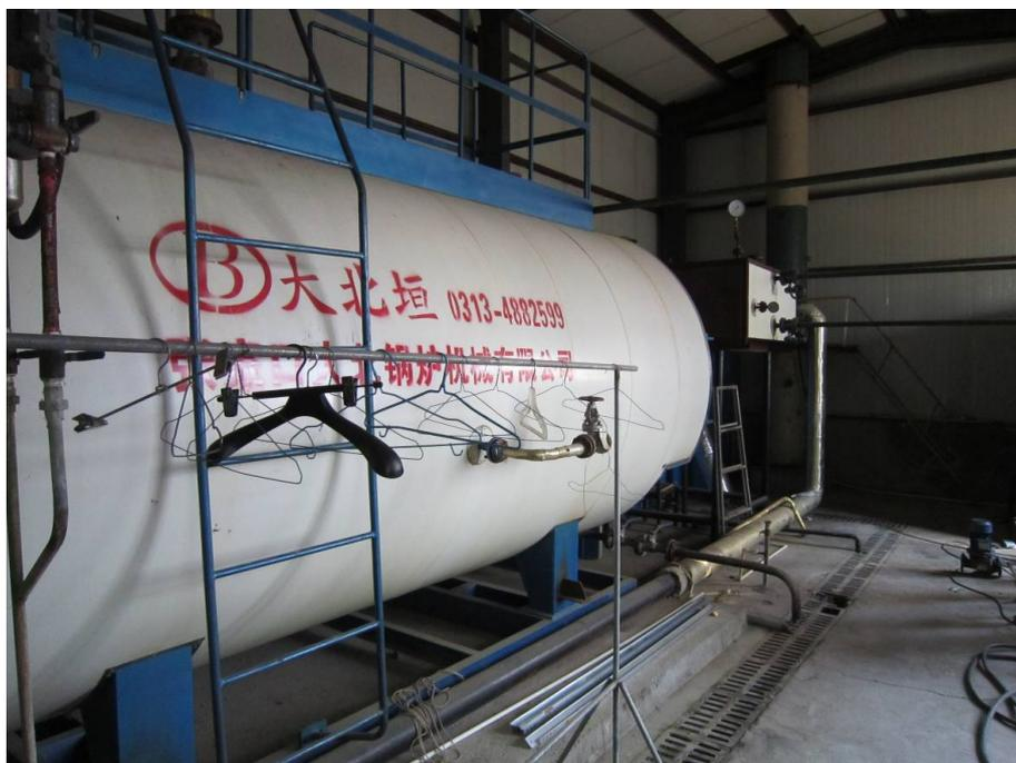
图 4-1 本项目锅炉房燃气蒸汽锅炉现状
