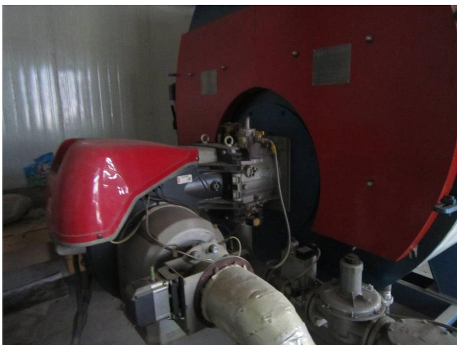
图 4-2 燃气蒸汽锅炉低氮燃烧器
