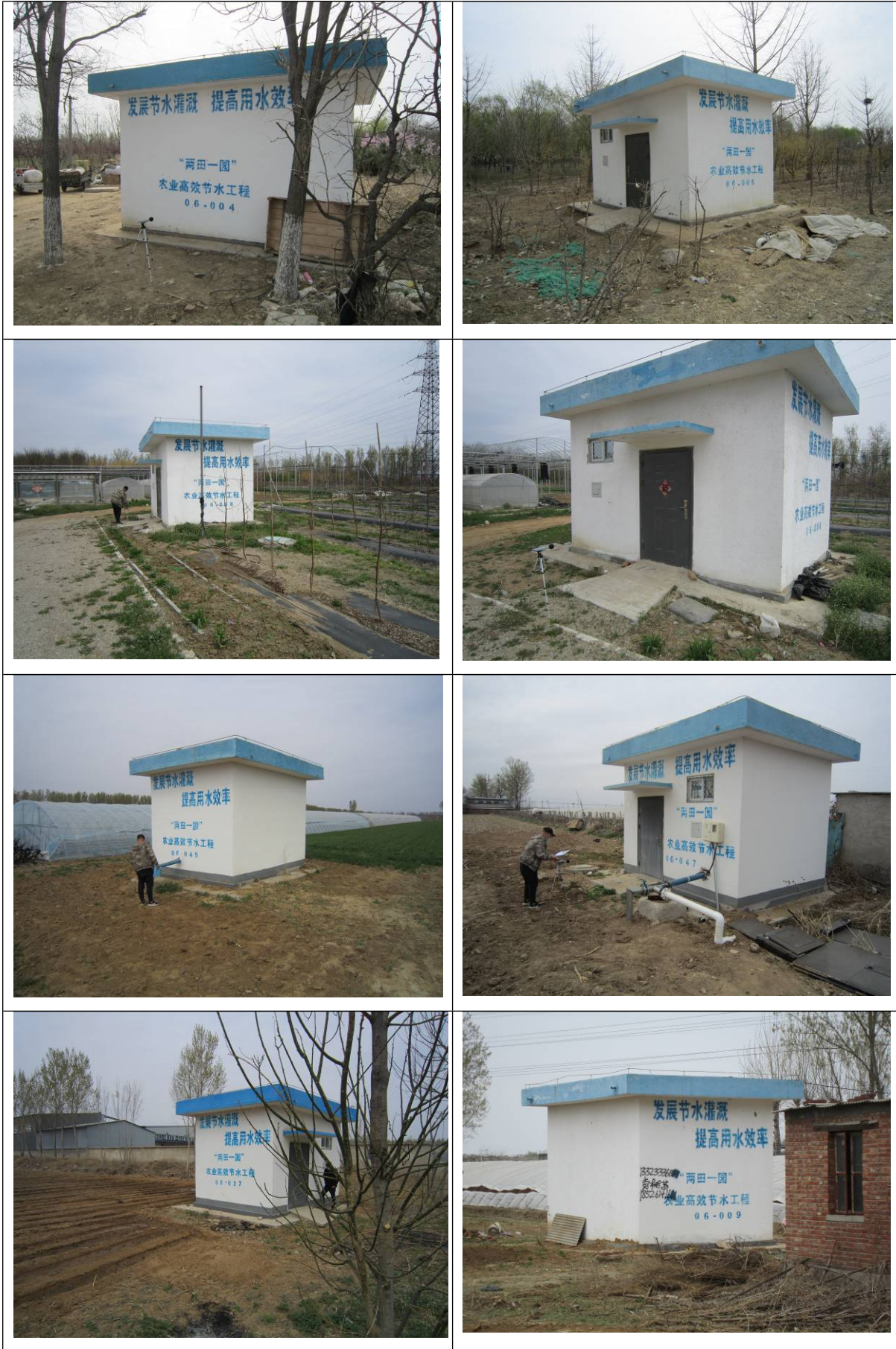
图 7-1 本项目现场监测（部分监测点）情况
