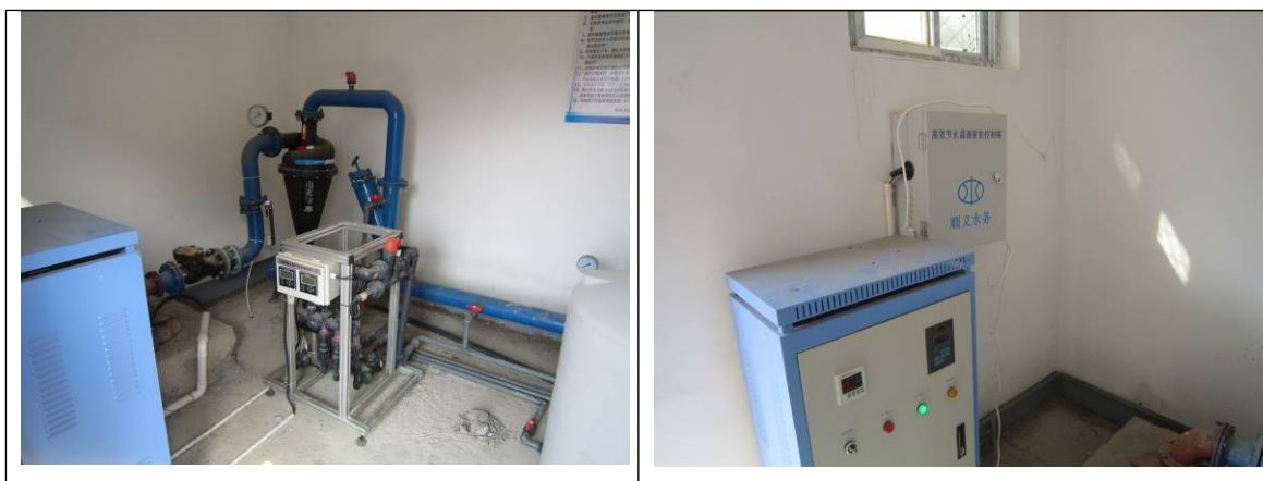
图3-3 井房内设施现状图
